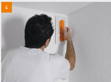
4 Spachtelung des Deckputzes
