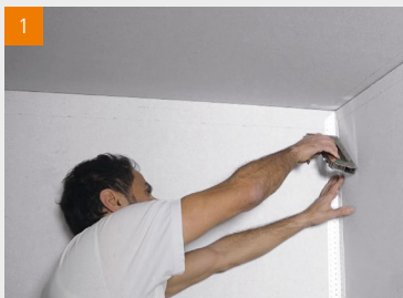
1 Vorbereitung der Innenecken
